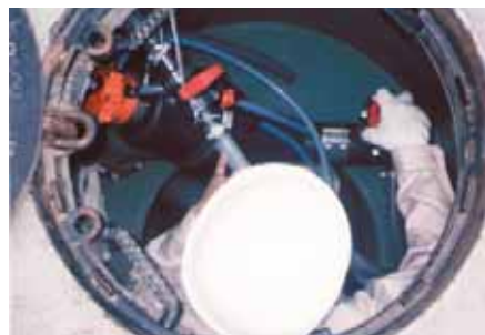
▲真空弁ユニット点検
