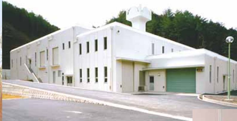
▲高知県四万十市衛生センター
